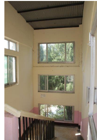
Réfection de la cage d'escalier
