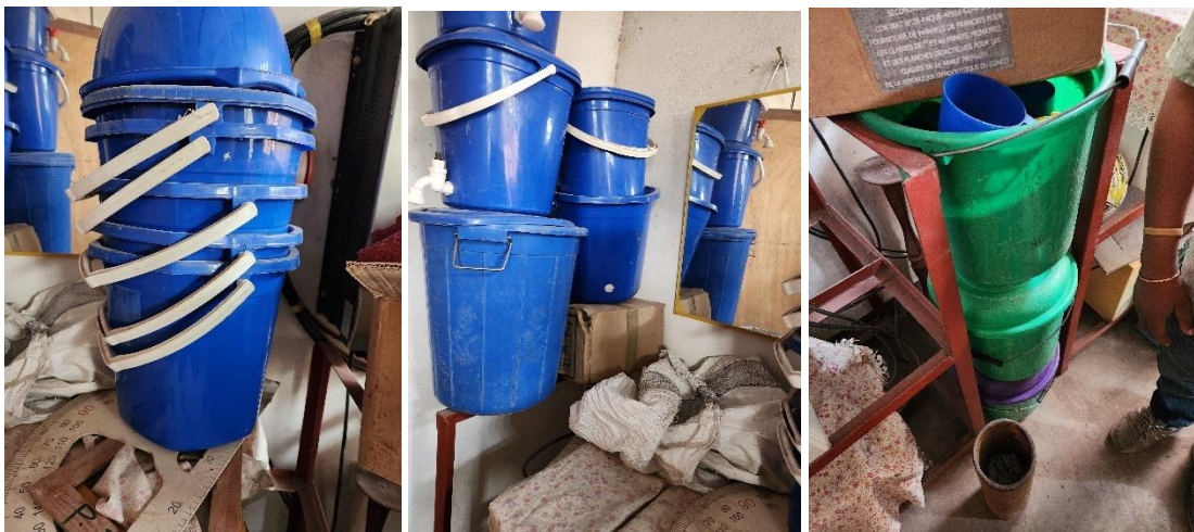
Handwaschstationen des Covid-19 Projekts in der Grundschule Petite Flamme in Ndjili
