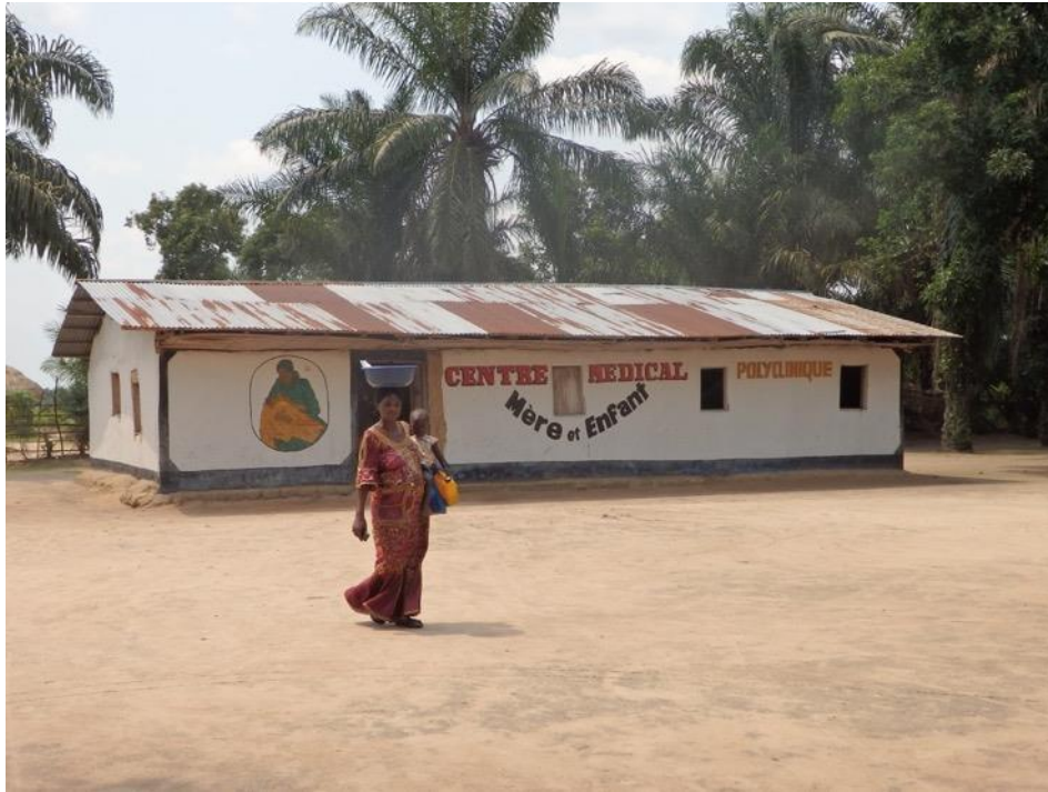
Visite du centre de santé Tshumbe I
